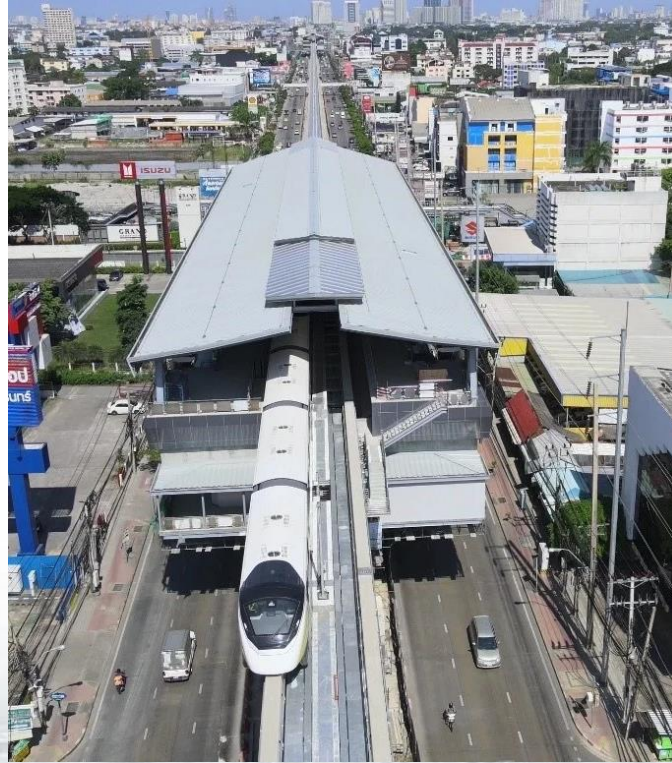
รถไฟฟ้าสายสีเหลือง สถานีศรีนครินทร์ 38
