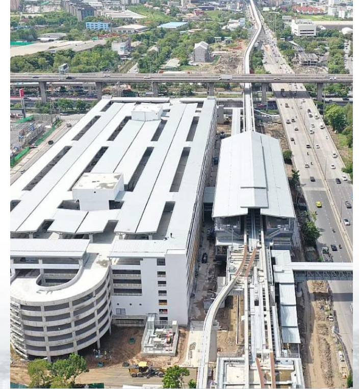
รถไฟฟ้าสายสีเหลือง สถานีศรีเอี่ยม
